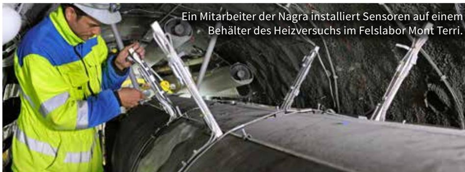
Ein Mitarbeiter der Nagra installiert Sensoren auf einem Behälter des Heizversuchs im Felslabor Mont Terri.
